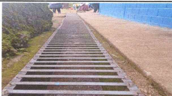
Foto 5: Parrillas instaladas de las cunetas
